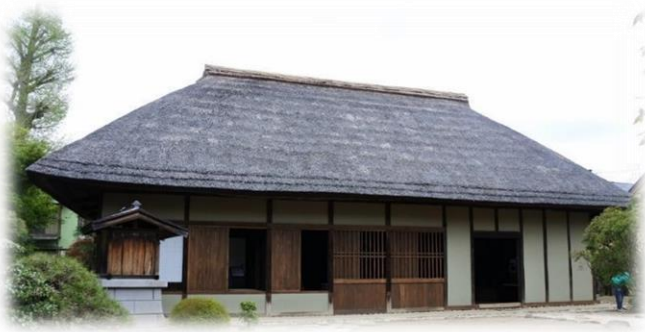
旧粕谷家住宅保存・修復(東京都板橋区)
